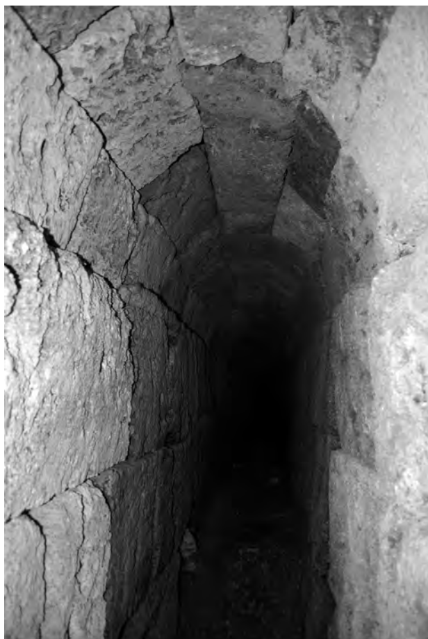
Fig. 113. Serravalle di Chienti, località Fonte delle Mattinate. Condotto idrico di epoca romana (SABAP AP-FM-MC).
