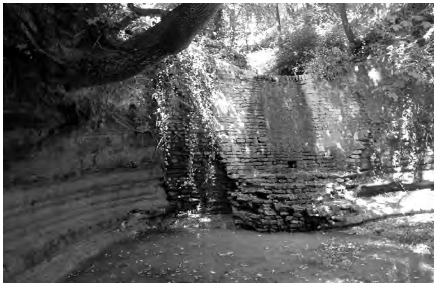
Fig. 32. Loro Piceno, resti di una struttura muraria di epoca repubblicana, in opera testacea e inserti lapidei, in C.da Vignali Bagnere (Archivio Unimc).
