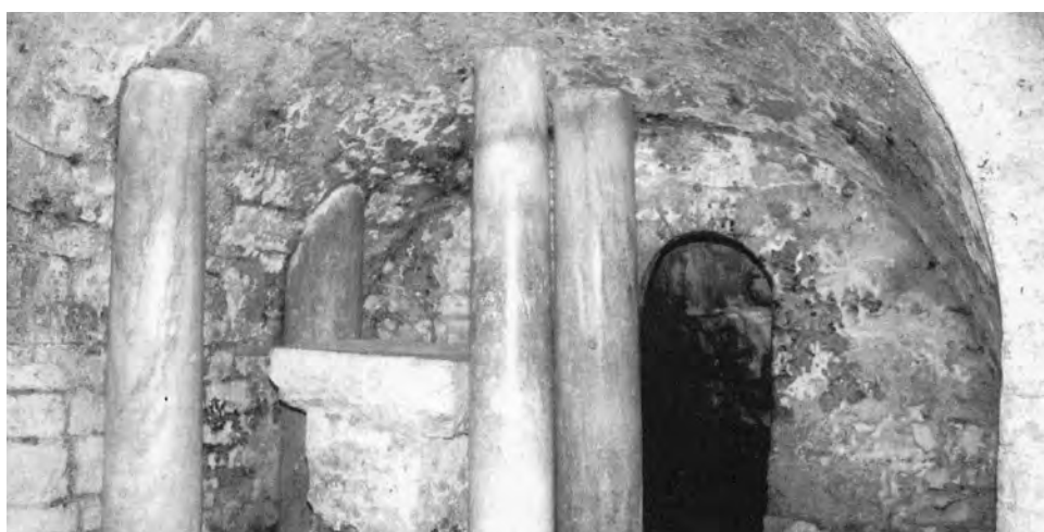
Fig. 73. Pievetorina, Chiesa di San Michele Arcangelo. Resti di membrature architettoniche e di un sarcofago, di età romana, reimpiegati nell'edificio (SABAP AP-FM-MC).
