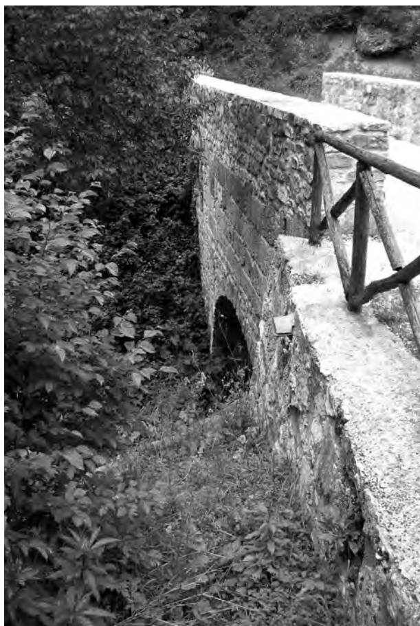
Fig. 68. Muccia, ponte romano in località Massaprofoglio (Archivio AMPM, CAM-M).
