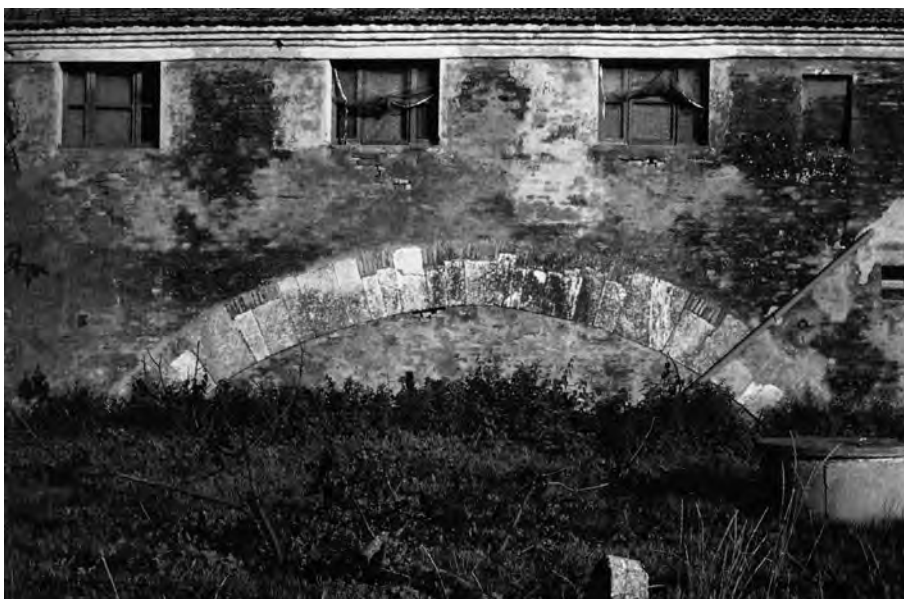
Fig. 92. Porto Recanati, cd. Casa dell'Arco, con resti inglobati di un ponte romano (SABAP AP-FM-MC).
