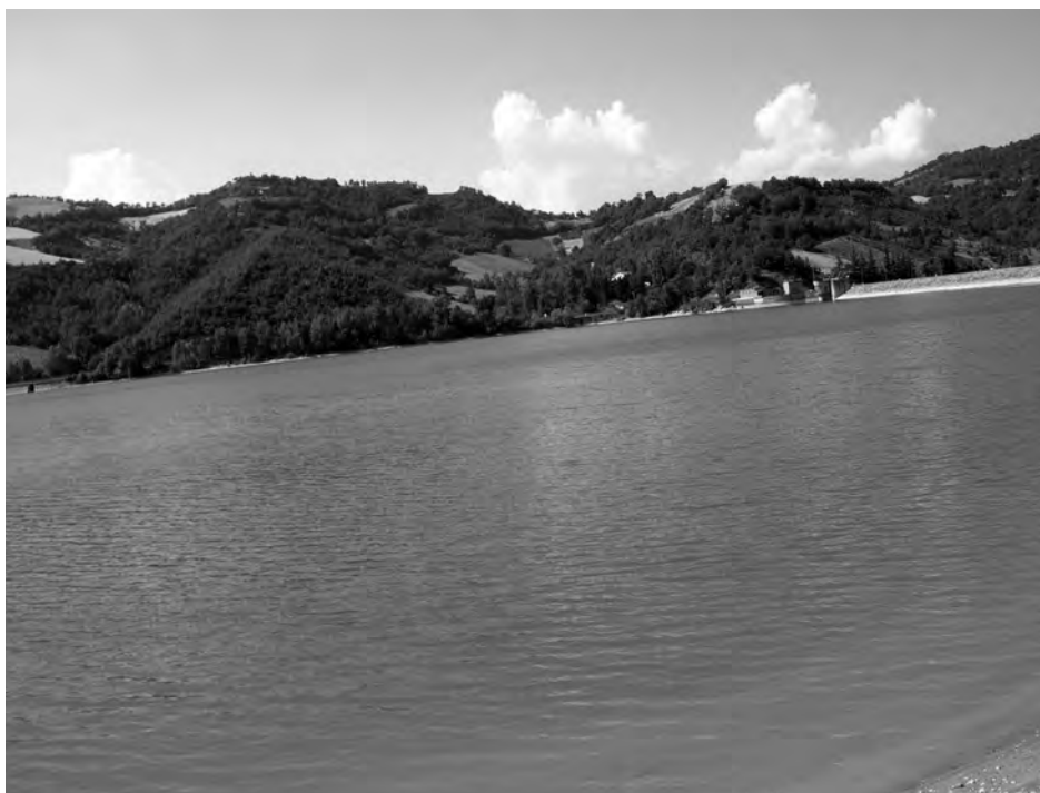
Fig. 153. Valfornace, località San Giovanni dell'Isola. Diga di Polverina (Archivio AMPM, CAM-M).
