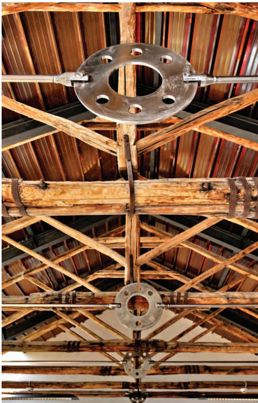
Fig. 26. Le nuove strutture di consolidamento del tetto
